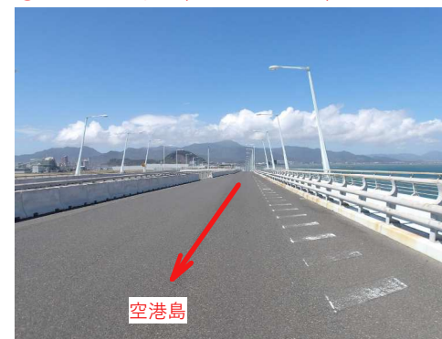
⑤車道ランプ橋（ONランプ出口）
