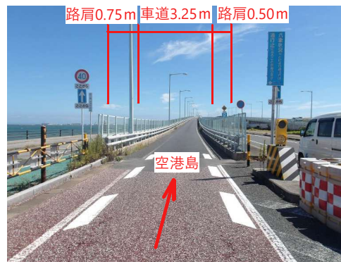
③車道ランプ橋（ONランプ入口）
