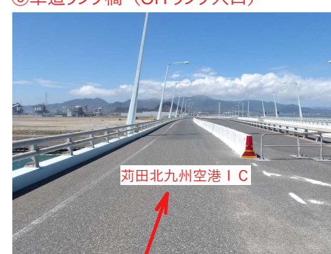
⑥車道ランプ橋（OFFランプ入口）
