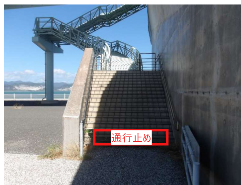
②通行止め箇所（新松山側歩行者階段）
