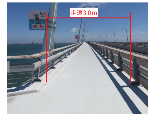
⑦連絡橋歩道部
